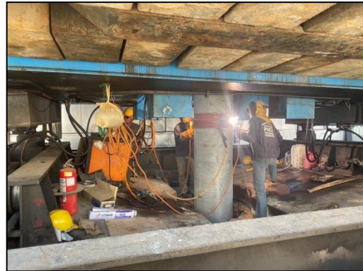
รูปที่ 29 การทำฐานรากแบบเสาเข็มกด
