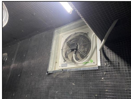
รูปที่ 25 พัฒนาระบายอากาศบริเวณห้องเครื่องกำเนิดไฟฟ้า
