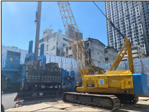
รูปที่ 29 การทำฐานรากแบบเสาเข็มกด
